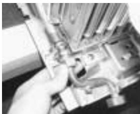
3. Roscar el conjunto mezclador al accesorio de salida del calentador (FEP-15DS).
