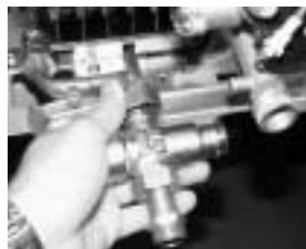
4. Roscar el conjunto mezclador a la salida de agua caliente del calentador (FEP-11DS).
