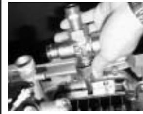
3. Enrosscar o conjunto misturador ao acessório de saída do esquentador (FEP-15DS).
