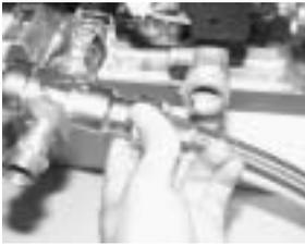
8. Conectar el grifo a la toma de agua fría de la pared y conectar el tubo flexible a la salida del grifo con su filtro.
