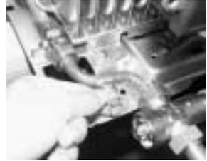
7. Conectar la toma de agua fría a la toma del mezclador marcada con un punto azul, usando el tubo flexible (racord 3/4").
